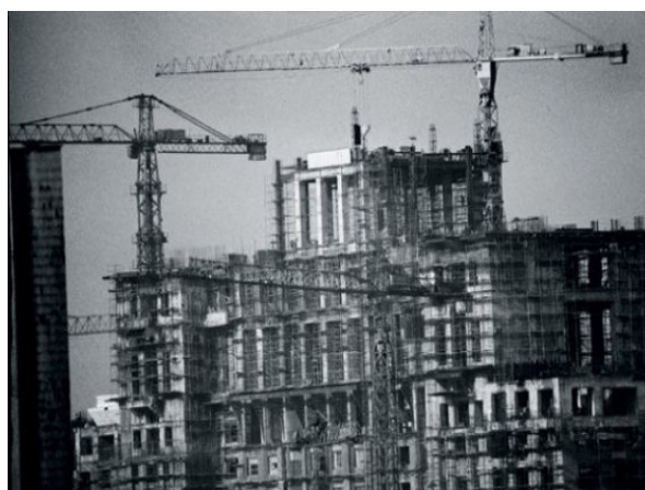
Figura 13. Casa Poporului în construcție
